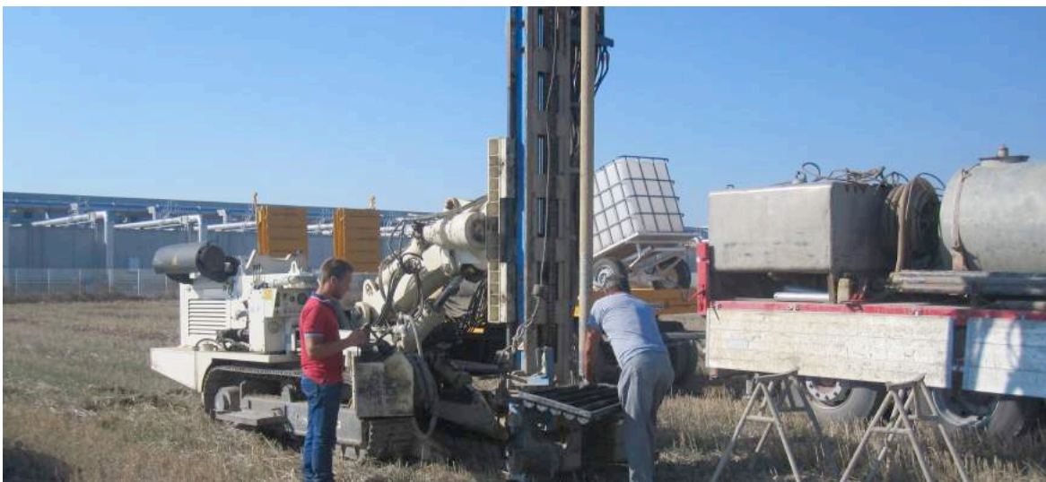
Foto N°2 Esecuzione Sondaggio S1
