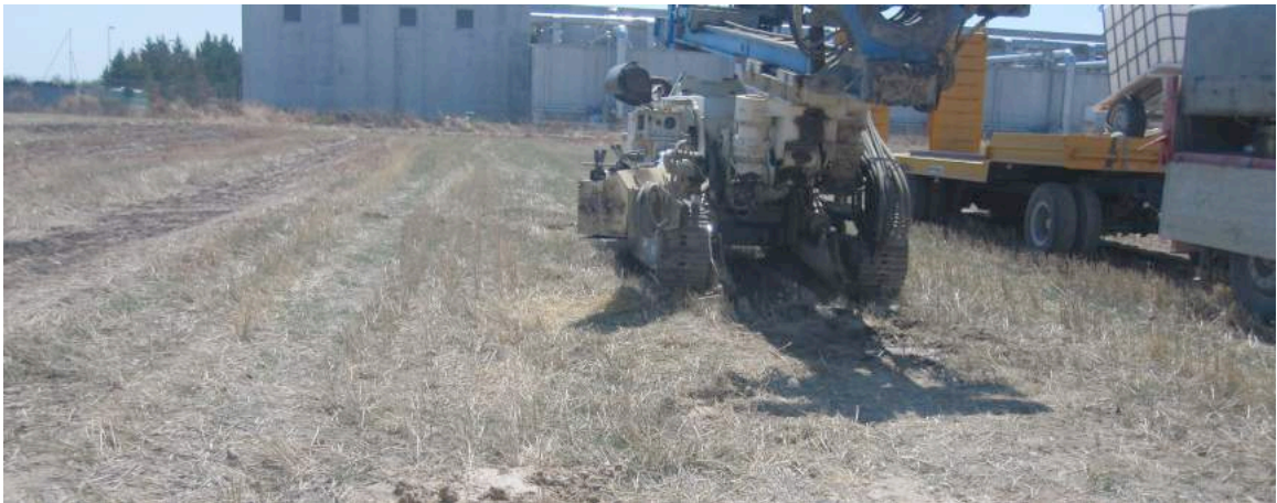
Foto N°1 Fase allestimento cantiere di perforazione
