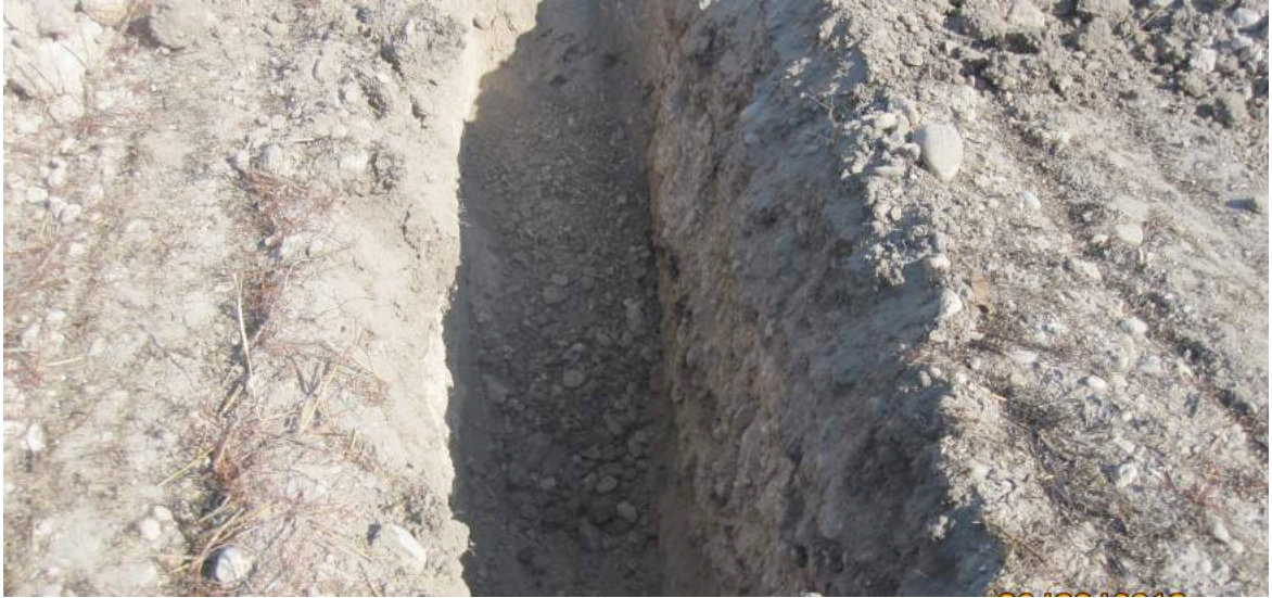
Foto N°5 Particolare Trincea esplorativa prelievo campioni
